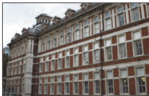
聖トマス病院に建てられたナイチンゲール病棟の外観。ナイチンゲールの考案による 3 層の窓から、常に新鮮な空気が確保できる構造になっている。(2010 年 8 月魚崎撮影)
