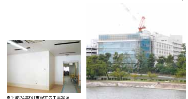
※平成24年9月末現在の工事状況
