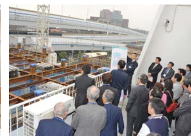
建設中の教育研究棟の工事現場を5号館の屋上から見学
