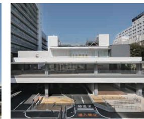
デッキ棟 東側外観
