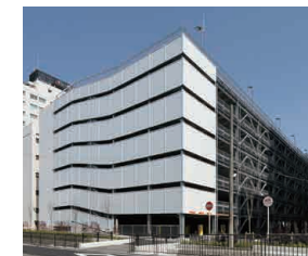
立体駐車場 南西面外観
