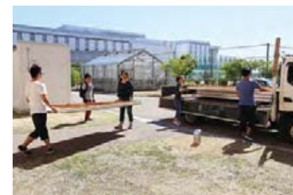
設管用資材の準備
