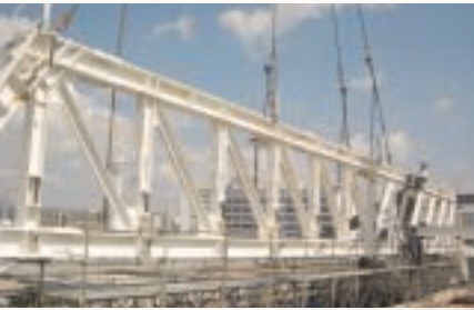
屋根鉄骨トラス建て込み( 10月 )
