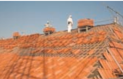
屋根瓦葺き( 11月 )
