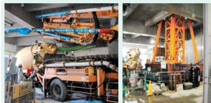
1階のポンプ車からクレーンに沿って7階までコンクリートを送り込んでいます。
