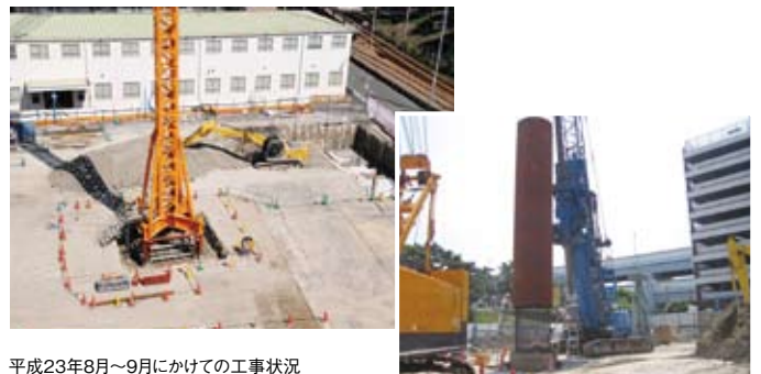
平成23年8月～9月にかけての工事状況
