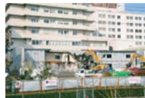
プレハブ舎の解体
