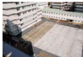
撤去後の様子(立体駐車場から)
