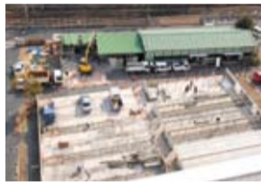
10号館東側施設解体工事
