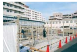
駐輪場の解体
